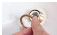
一番始めに外した固定リングを セットして、灯具を固定します。
